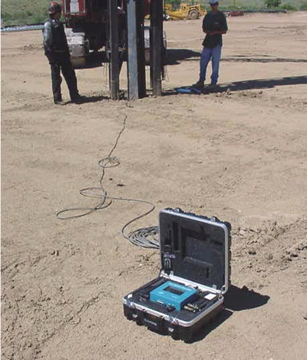
Bild 5: Rammpfähle: PDA mit Telefonverbindung im Einsatz
