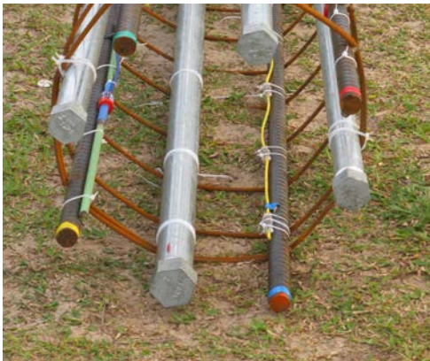
Figura 15: Vista da instrumentação instalada na armadura da estaca. O Thermal Wire® é o fio amarelo.
