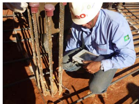
Figura 1: Execução de ensaio PIT.
