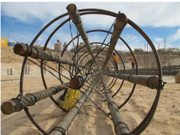
Figura 10: Vista do fio fixado na barra centralizada em relação a seção transversal da armadura.
