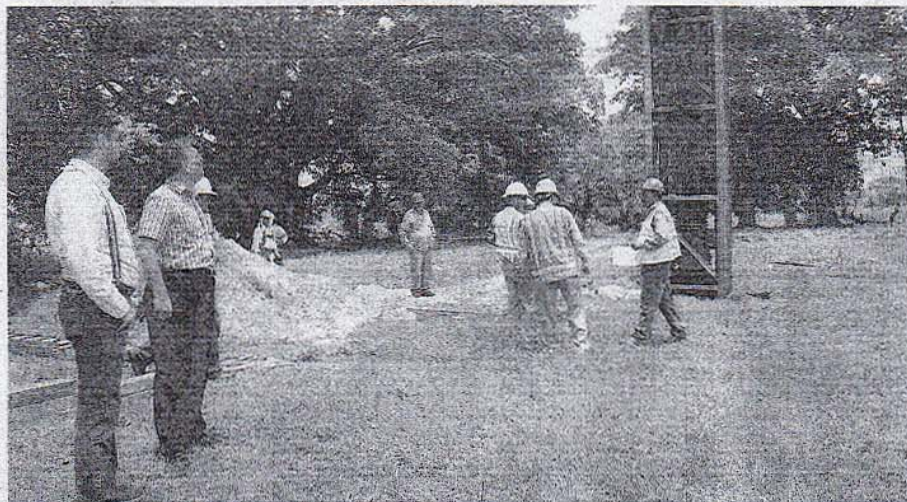
Los expertos internacionales están realizando estudios de suelos para garantizar la seguridad.
