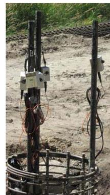
Figura 3 - Fiação térmica
