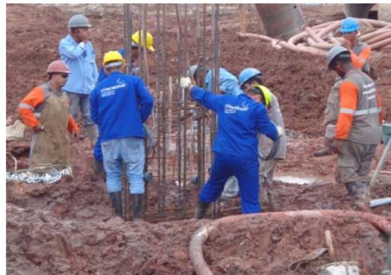
Figura 7 – Clipagem das armaduras instrumentadas
