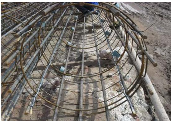
Figura 5 – Fiação Térmica posicionada na armadura
