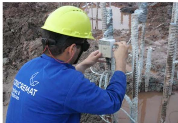
Figura 8 – Fixação dos coletores (TAP) para registro
