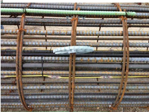
Figura 4. Fiação térmica acoplada à armadura
