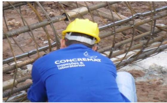
Figura 6 – Fixação da instrumentação na armadura
