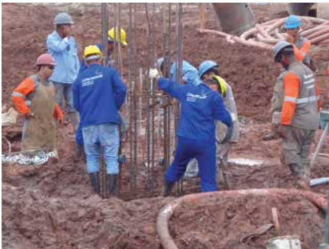
Figura 6: Clipagem das armaduras instrumentadas
