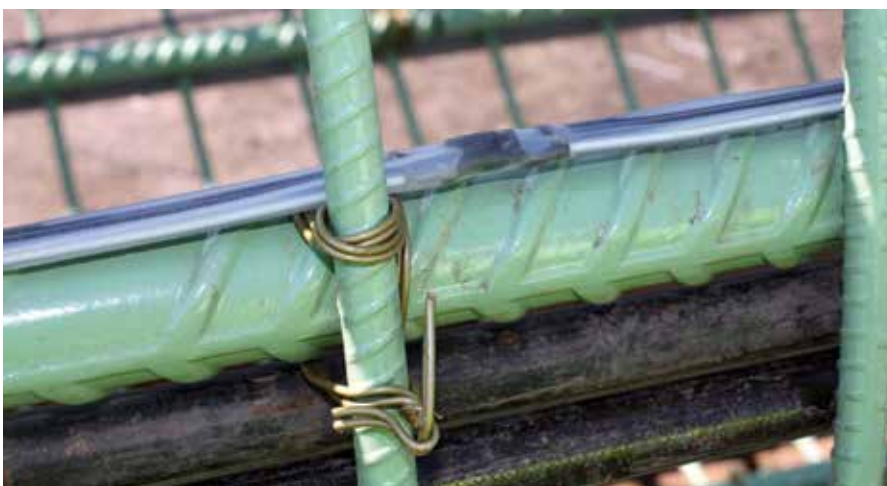
Figura 3: Fiação térmica acoplada à armadura
