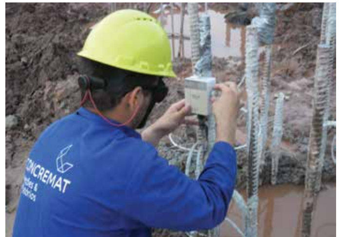
Figura 7: Fixação dos coletores (TAP) para registro
