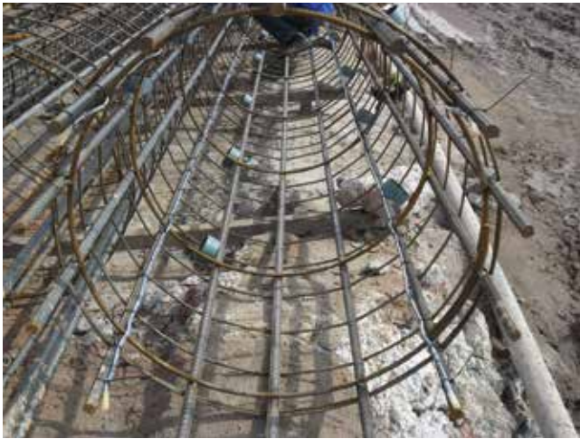
Figura 4: Fios térmicos posicionados na armadura
