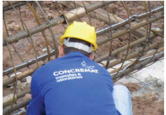
Figura 5: Fixação da instrumentação na armadura
