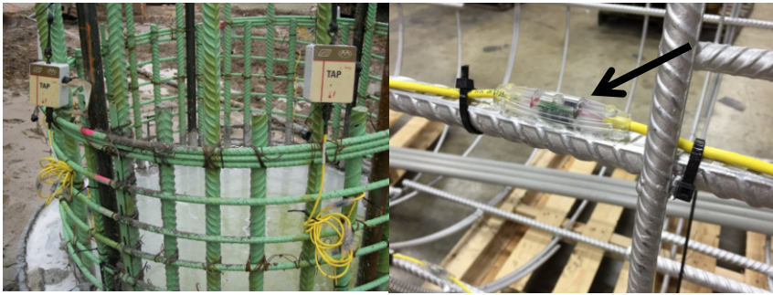
Figura 2. Alambres (amarillos) con sensores térmicos (indicados por una flecha) pegados a la armadura de refuerzo.
