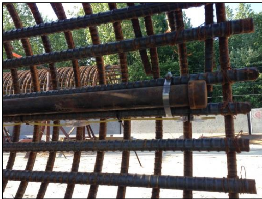
FIG. 9. Thermal Wire® cable on Rebar
