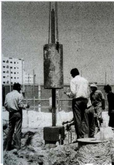
Abb 1: Einfache dynamische Pfahlprüfung an einem Bohrpfahl
