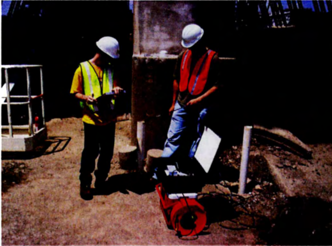
Bild 4: Induktivmessungen in PVC verrohrten Bohrlöchern
