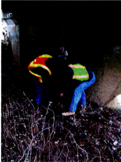
Bild 1: Einsatz einer leichten Rammsonde unter einer Brücke
