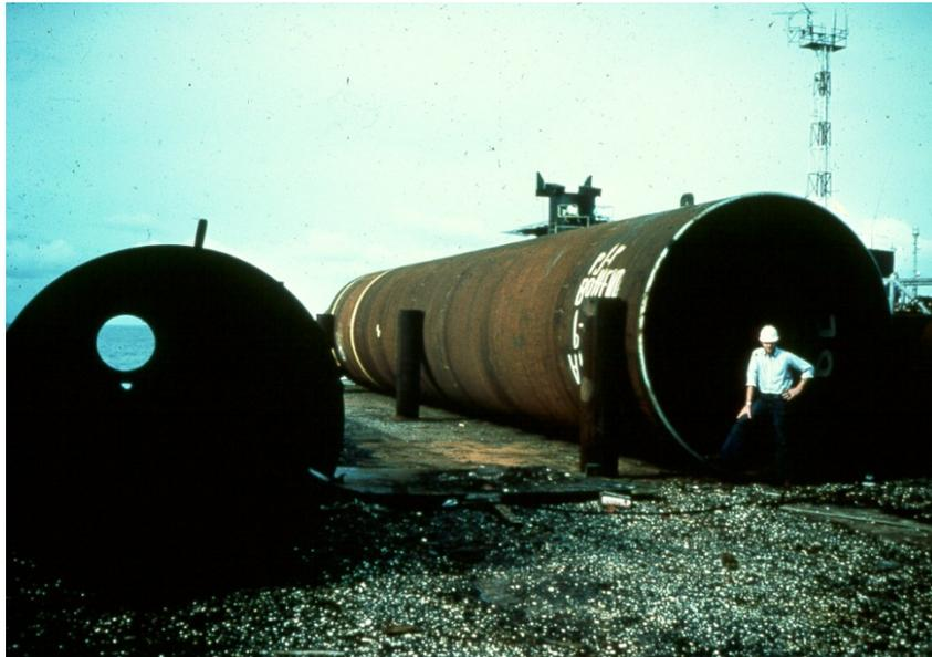
Bild 1: Rohrpfahl von 3660 mm Durchmesser
